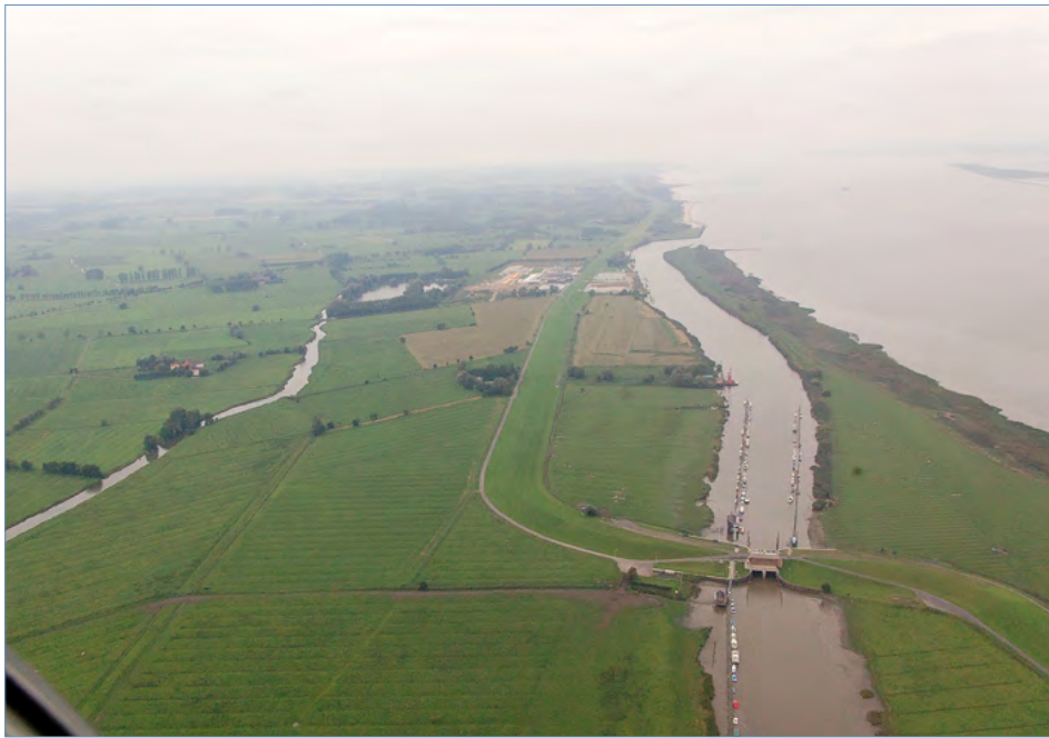
Das Ruthenstrom-Sperrwerk bei Drochtersen kurz vor Einnündung des Flüsschens in die Untere Elbe: Unter diesem Bau soll nach den Vorstellungen der Planer der künftige Autobahntunnel die Elbe queren.
